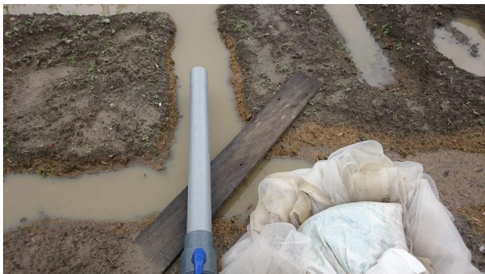
圖 7. 布設管路將水引至內環溝
