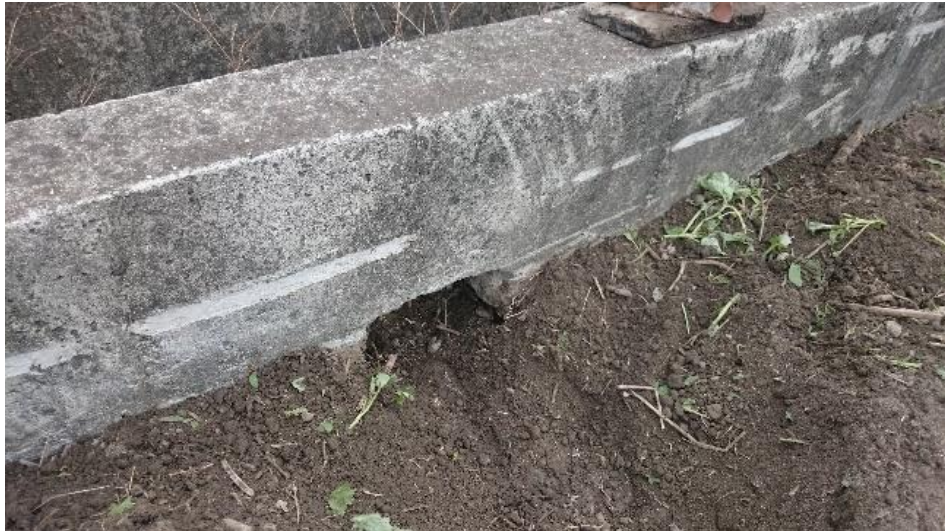
圖 6. 確認排水口暢通
